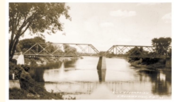
Vue latérale du pont Reed-Séguin sans les passerelles, vers 1940. Carte postale. Collection Jean-Guy Venne.
