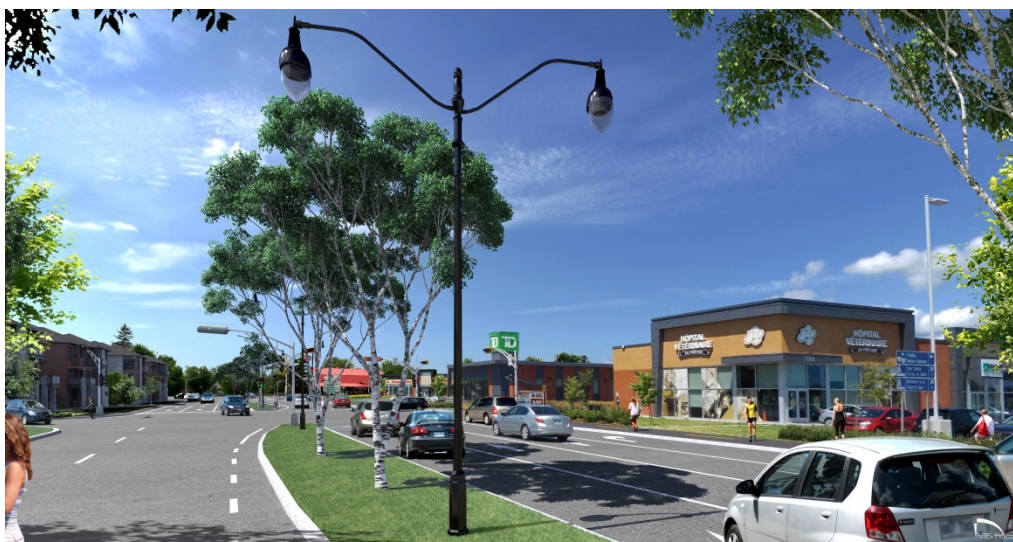
Réaménagement de la montée de Saint-Sulpice
